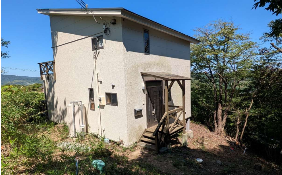
現況外観写真
